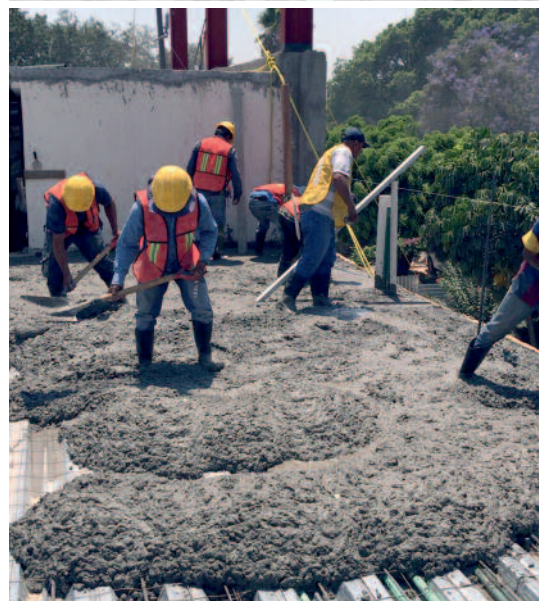
Die Liebe drängt: Die Arbeiten am neuen Haus haben begonnen.
