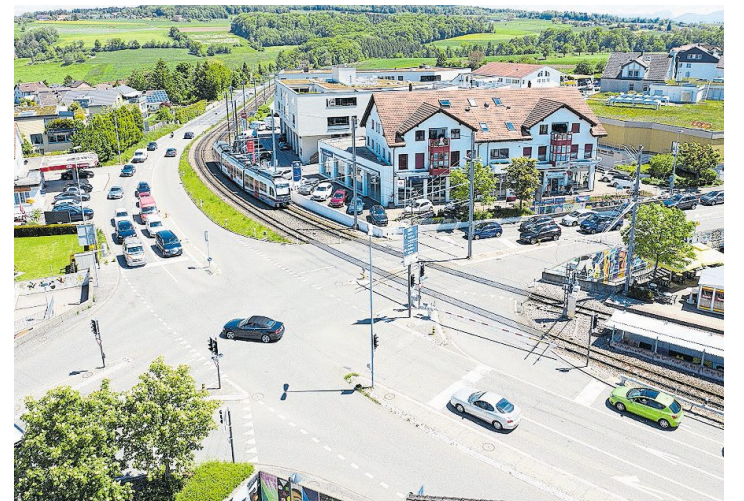
Auf der Mutschellen-Kreuzung werden die Gleise erneuert. Bild: zvg
